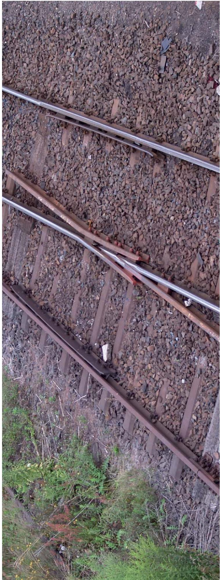
Anordnung der Radlenker an einer teiltrückgebauten Weiche in Halle/Saale Gbf
